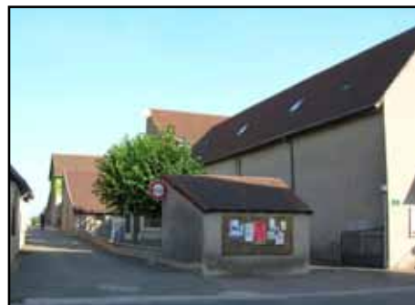
Emplacement de la future extension.
