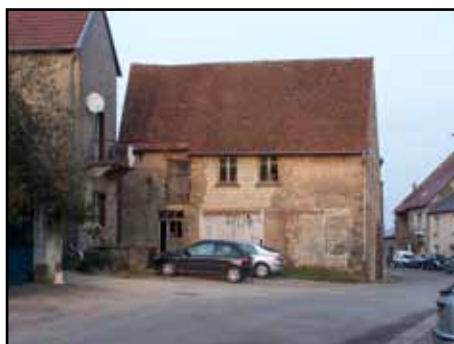
Bâtiment à démolir.
